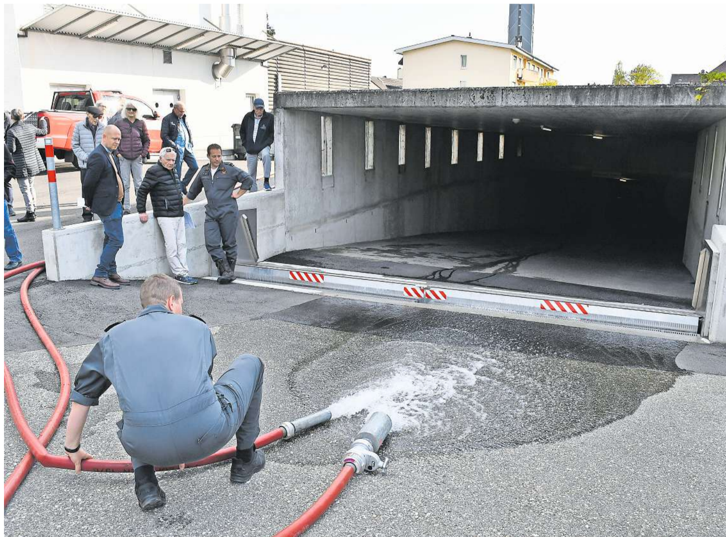
Kommt eine gewisse Menge an Wasser, stellt sich das Klappschott beim Garageneingang auf. Das wurde am Dienstag gemeinsam mit Angehörigen der Feuerwehr Zofingen getestet. Bilder: Janine Müller
